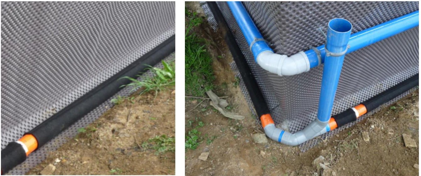
Figure 7 : Exemples d'installation du BâtiFIBRE®-SN4 sur vide sanitaire
