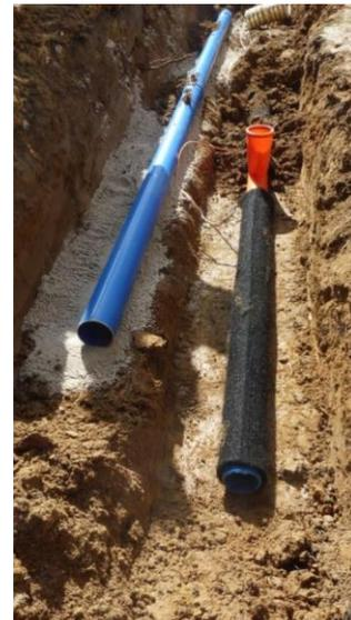
**Figure 13 : Exemples de raccordement du BâtiFIBRE® avec un complexe de drainage vertical**
