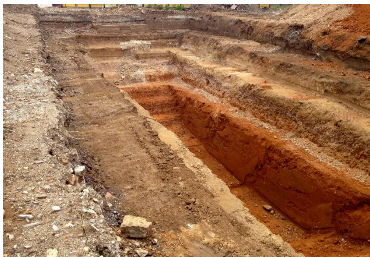
FIGURE N°3 : EXCAVATION DE RECONNAISSANCE DES SOLS (FOSSE PEDOLOGIQUE)
