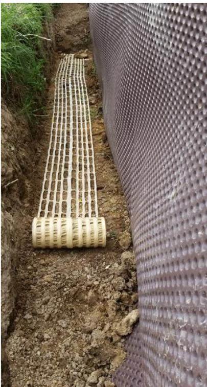
**FIGURA n°27: INSTALACIÓN DE UNA MALLA DE ADVERTENCIA**
