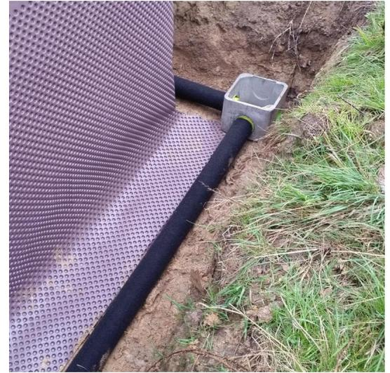
**FIGURA N°18: CAMBIO DE SENTIDO CON UNA CAJA DE INSPECCIÓN**
