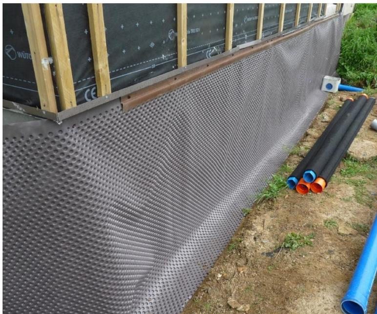
**FIGURA N°12: INSTALACIÓN DE UN FILM GOFRADO PARA LA PROTECCIÓN DE LA ESTANQUEIDAD**
