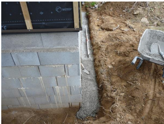
FIGURA N°8: REALIZACIÓN DE LA CUNETAS EN HORMIGÓN POBRE & COMPROBACIÓN DE LAS PENDIENTES
