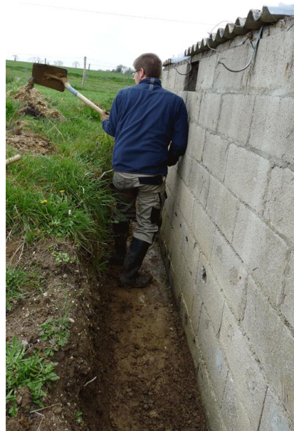
FIGURA N°3: DESPEJAR LOS CIMIENTOS CON UNA PALA EXCAVADORA MECÁNICA Y REALIZAR LOS ACABADOS CON UNA PALA A MANO
