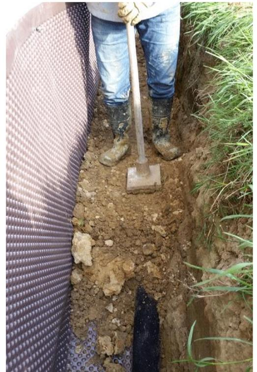
**FIGURA n°26: COMPACTADO MANUAL DE LAS CAPAS DE TERRAPLENADO**
