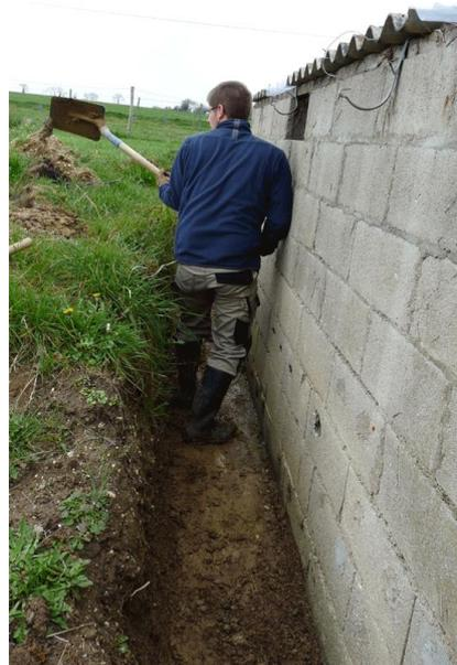
**FIGURA N°3: DESPEJAR LOS CIMIENTOS CON UNA PALA EXCAVADORA MECÁNICA Y REALIZAR LOS ACABADOS CON UNA PALA A MANO**
