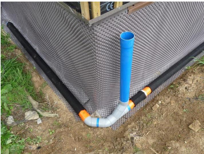
**FIGURA N°19: CAMBIO DE SENTIDO CON DOS CODOS A 45° PVC Ø100**
