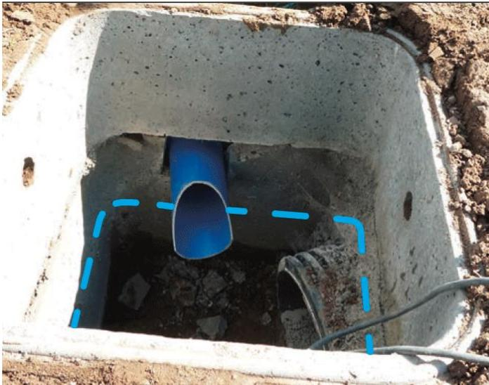
**FIGURA n°1: CONEXIÓN DE LA RED DE DRENAJE A UN DESAGÜE**
