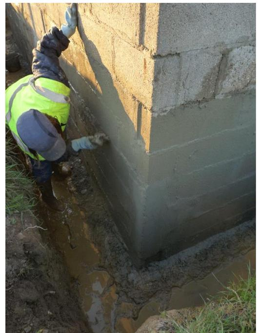
**FIGURA N°11: APLICACIÓN DE UN PRODUCTO DE ESTANQUEIDAD**
