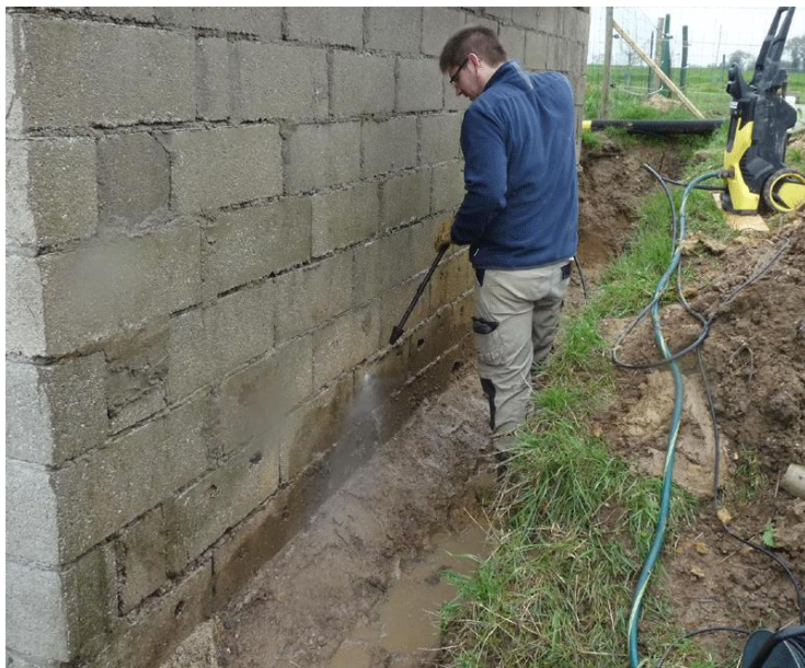
FIGURA n°4: DESINCRUSTAR LAS SUPERFICIES CON UN LIMPIADOR DE ALTA PRESIÓN
