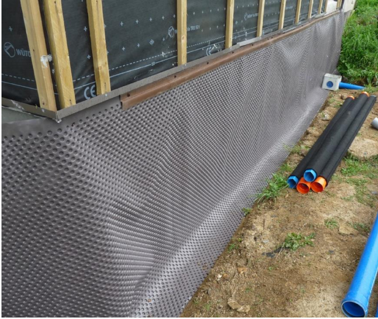
FIGURA N°12: INSTALACIÓN DE UN FILM GOFRADO PARA LA PROTECCIÓN DE LA ESTANQUEIDAD
