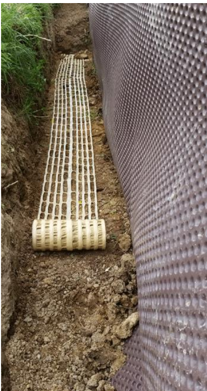
FIGURA n°27: INSTALACIÓN DE UNA MALLA DE ADVERTENCIA
