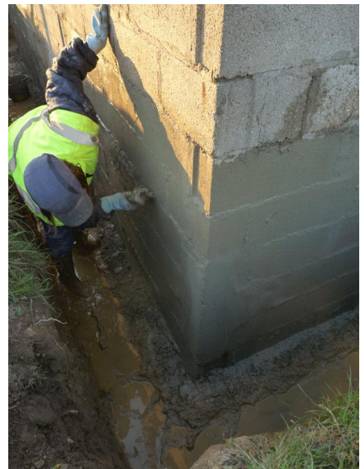
FIGURA N°11: APLICACIÓN DE UN PRODUCTO DE ESTANQUEIDAD
