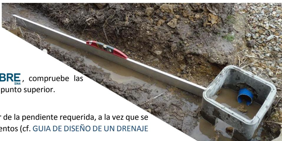
**FIGURA N°13: COMPROBACIÓN DE LAS PENDIENTES ANTES DE COLORAR EL DRENAJE BATIFIBRE<sup>SN4</sup> A DISTANCIA DE LOS CIMIENTOS**
