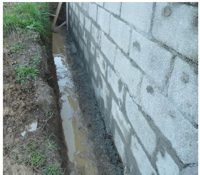
FIGURA n°5: REJUNTAR LOS REVESTIMIENTOS DE LOS CIMIENTOS
