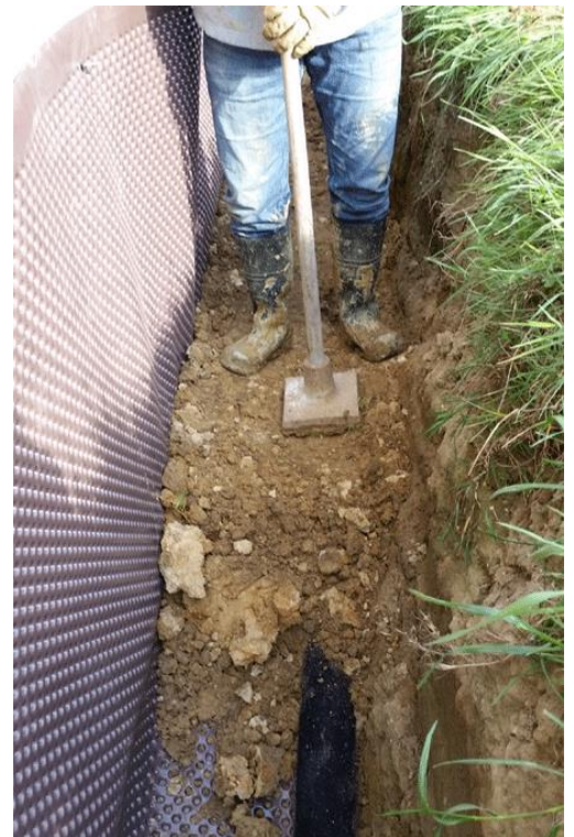
FIGURA n°26: COMPACTADO MANUAL DE LAS CAPAS DE TERRAPLENADO
