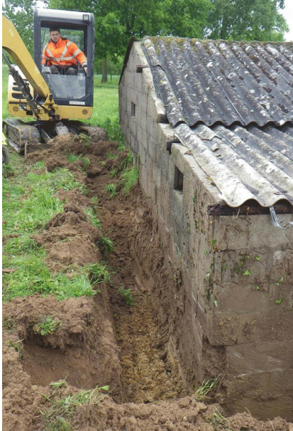
FIGURA N°3: DESPEJAR LOS CIMIENTOS CON UNA PALA EXCAVADORA MECÁNICA Y REALIZAR LOS ACABADOS CON UNA PALA A MANO
