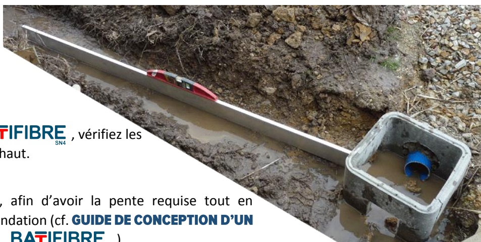
FIGURE N°13 : VERIFICATION DES PENTES AVANT LA MISE EN ŒUVRE DU DRAIN BATIFIBRE SN4 A DISTANCE DES FONDATIONS
