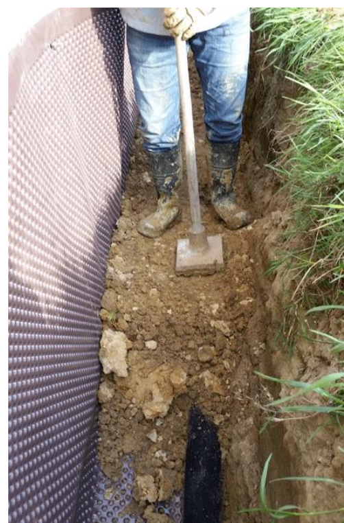
FIGURE N°26 : DAMMAGE MANUEL DES COUCHES DE REMBLAIS
