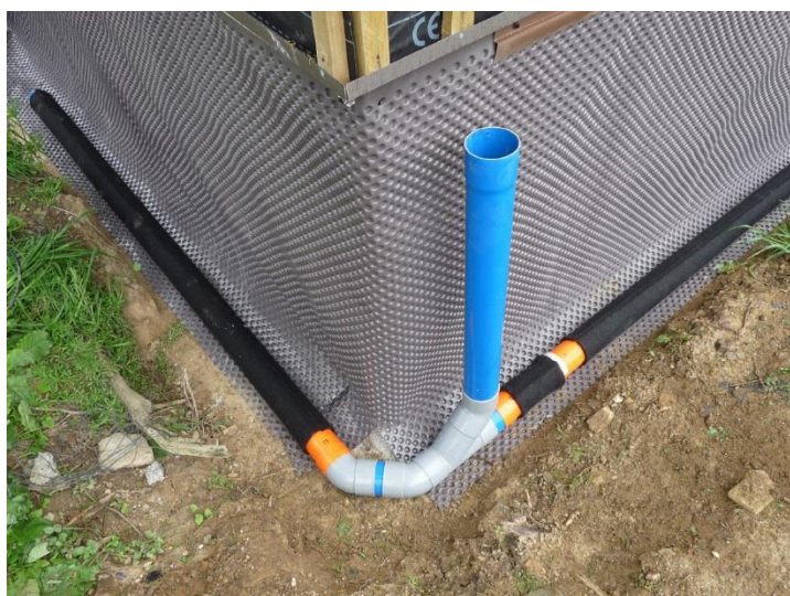
FIGURE N°19 : CHANGEMENT DE DIRECTION A L'AIDE DE DEUX COUDES A 45° PVC Ø100
