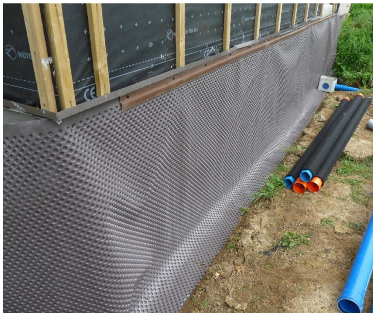
FIGURE N°12 : MISE EN ŒUVRE D'UN FILM GAUFRE POUR PROTECTION DE L'ETANCHEITE
