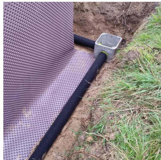
FIGURE N°18 : CHANGEMENT DE DIRECTION AVEC UNE BOITE D'INSPECTION
