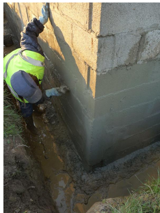
FIGURE N°11 : MISE EN ŒUVRE D'UN PRODUIT D'ETANCHEIFICATION
